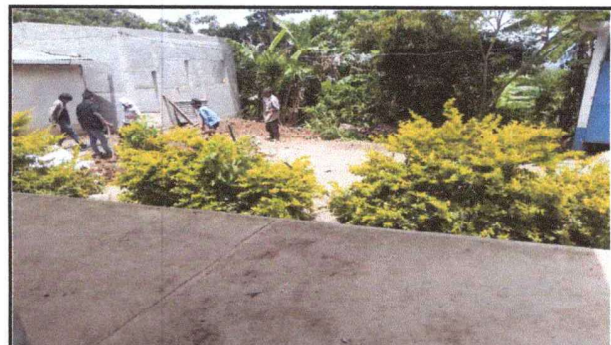
Foto 4: trabajando en el concreto alisado
