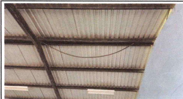
Foto 5: trabajando en la cubierta de alamina
