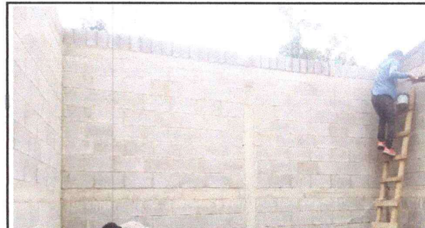
Foto 6: trabajando en la cubierta de lamina
