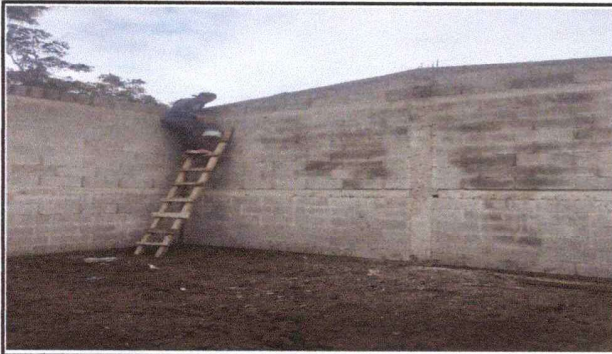
Foto1: trabajando en la sustitucion de lamina, sustitucion de muro blok
