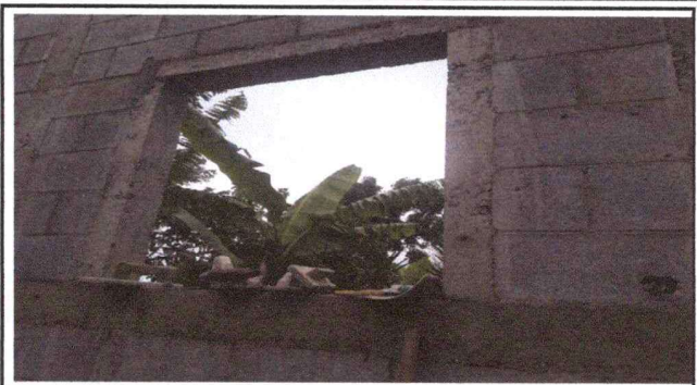
Foto 2: Ttrabajando en la sustitucion de puertas y ventanas,
