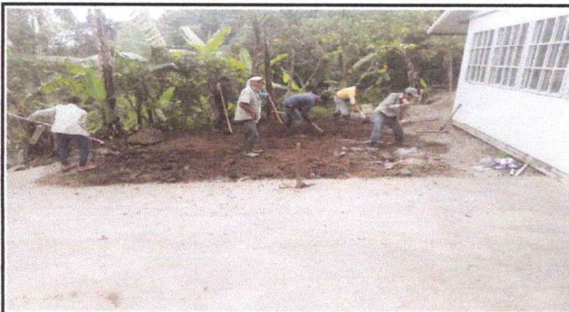
Foto 3: trabajos en la losa de patio.
