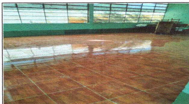
Foto 3: PISO DE AULAS
