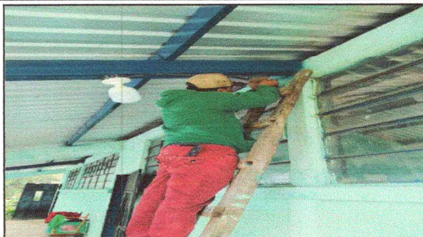
Foto 2: MANTENIMIENTO DE LUZ ELECTRICA
