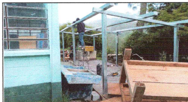
Foto 6: ESTRUCTURA DE COCINA DE Párvulos
