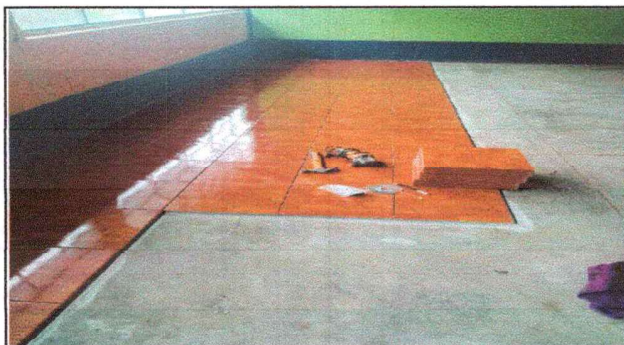
Foto 3: PISO DE AULAS
