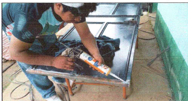
Foto 5: MANTENIMIENTO DE PUERTAS
