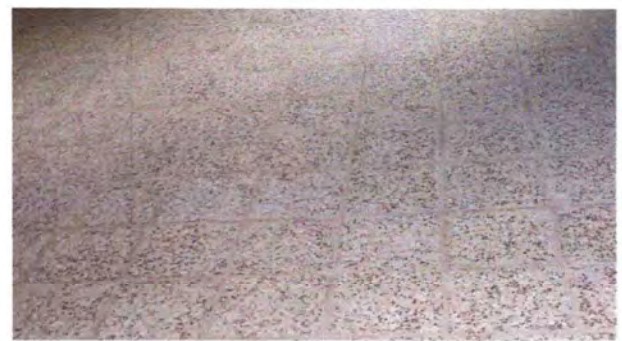
Foto 4: PISO (SUSTITUCION PISO DE GRANITO, BASE Y COLOCACION)
