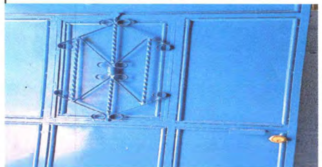
Foto 2 : PUERTA (AULA MANTENIMIENTO Y CAMBIO DE CHAPA)
