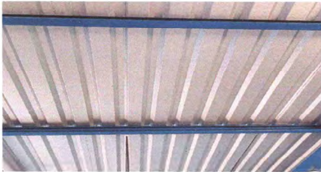
Foto 1: CUBIERTA DE LAMINA (SUSTITUCION) Y ESTRUCTURA DE TECHO (MANTENIMIENTO, LIMPIEZA Y PINTURA)
