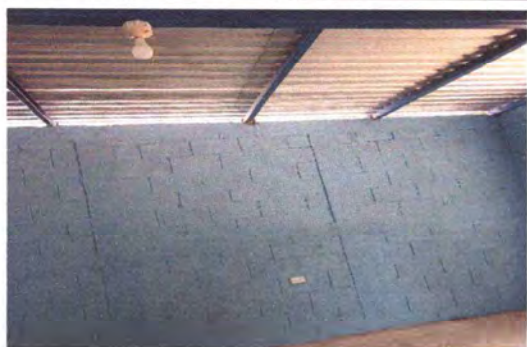
Foto 7: REPARACION DE SISTEMA ELECTRICO (SUSTITUCION)
