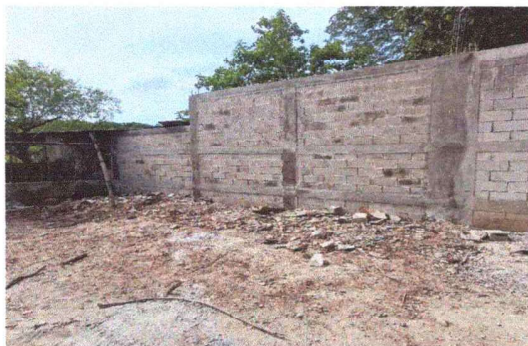
Foto 1: CERCO O MURO PERIMETRAL (SUSTITUCION DE MURO DE BLOCK)
