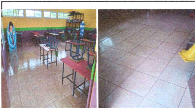
Foto1: TERMINADO LA SUSTITUCION DEL PISO
