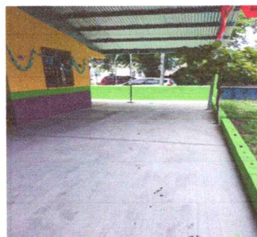
Foto 6: TERMINADO LA PINTURA DEL INTERIOR Y EXTERIOR
