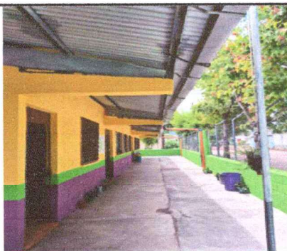
Foto 5: TERMINADO LA PINTURA DEL INTERIOR Y EXTERIOR
