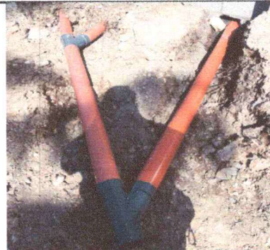
Foto 6: TRABAJANDO EN LA RED DE DRENAJES Y RED DE AGUA POTABLE
