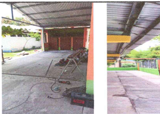
Foto 3: TRABAJANDO EN LA LOSA DE PATIO
