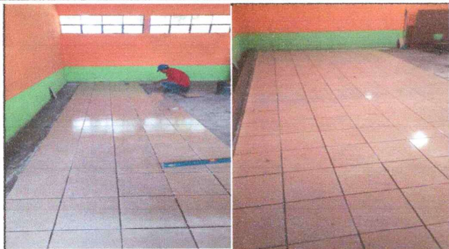
Foto1: TRABAJANDO EN LA SUSTITUCIÓN DE PISO
