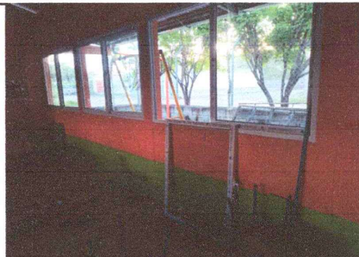
Foto 2: TRABAJANDO EN LA SUSTITUCIÓN DE VENTANAS
