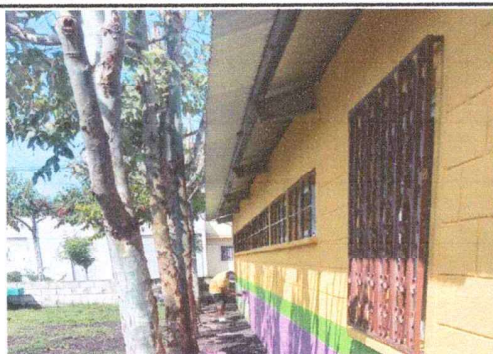
Foto 5: TRABAJANDO EN LA PINTURA EXTERIOR
