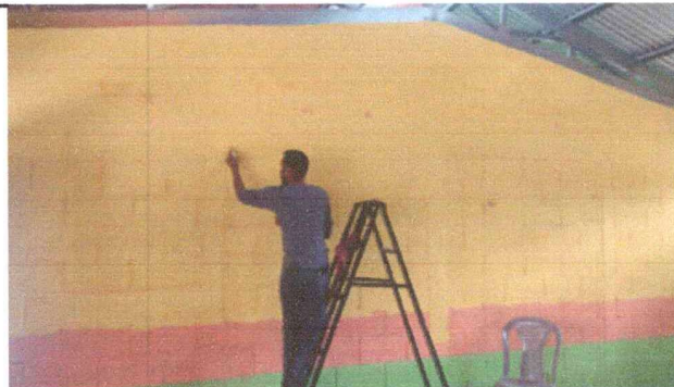
Foto 4: TRABAJANDO EN LA PINTURA DEL INTERIOR
