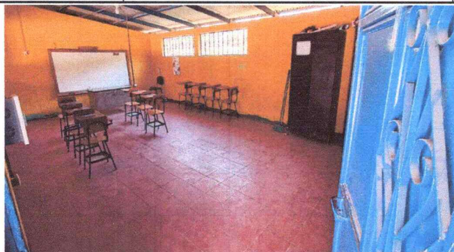
Foto #1 Instalación de piso cerámico en aulas y corredor de la escuela área común.
