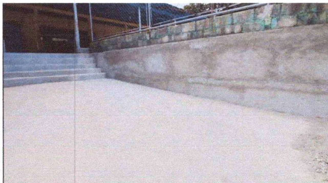
Foto: Repello y cernido tipo granceado en pared de muro de cancha (área común)
