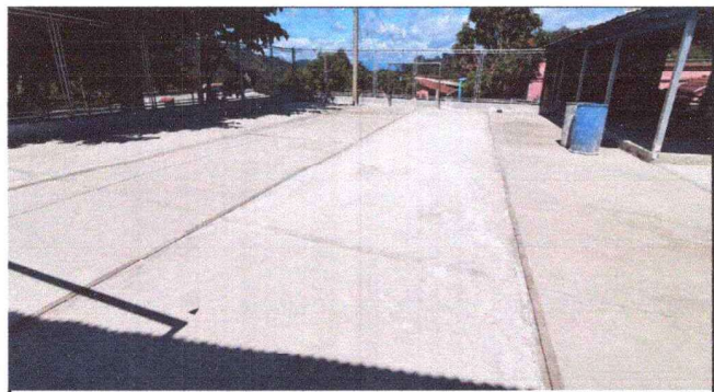
Foto #3 Fundición de losa de patio en cancha deportiva de la escuela área común.
