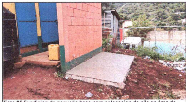
Foto #5 Fundición de pequeña base para colocación de pila en área de sanitarios.
