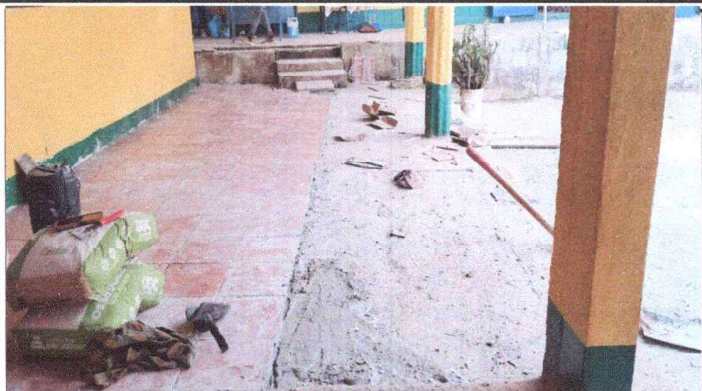
Foto 1. Proceso de instalación de piso ceramico en aulas y corredor de la escuela.
