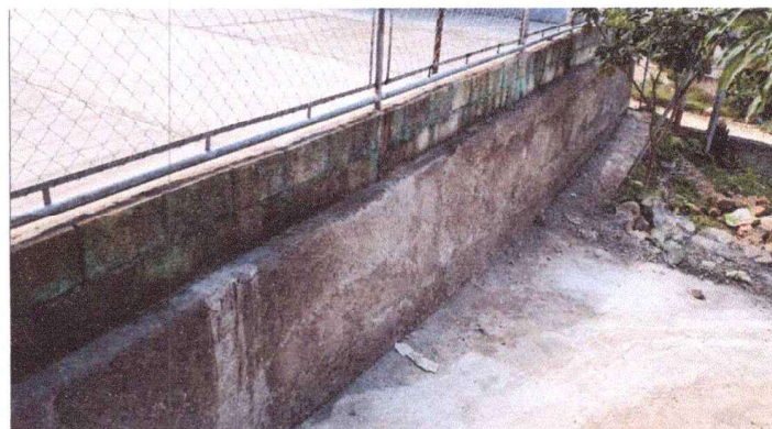
Foto 4: Proceso de repello de pared de muro de cancha deportiva.
