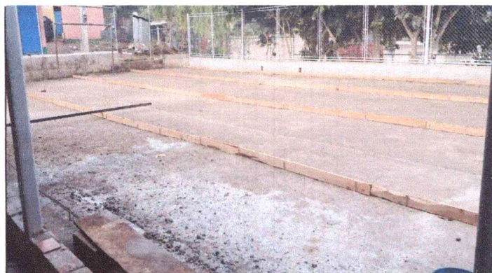
Foto: Formaleta para fundicion de losa de patio en cancha deportiva área común.
