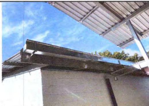
Foto 4: Sustitución de canales pluviales
