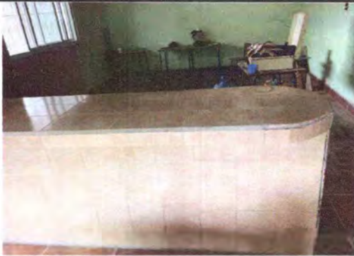
Foto 7: sustitucion de azulejo
