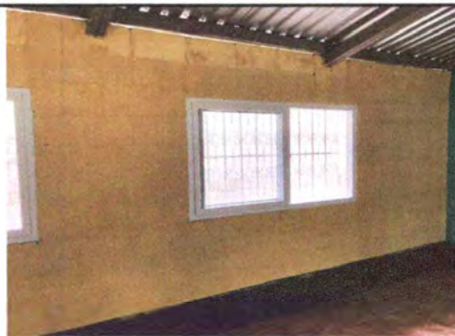
Foto 2: Sustitución de ventanas
