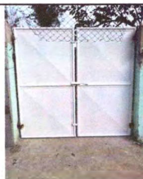
Foto 6: Reparación de porton de ingreso principal
