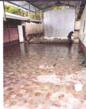
Foto 8: Sustitucion de losa de patio
