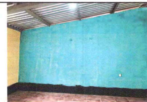
Foto 5: sustitución de pintura de agua para exterior y pintura de aceite en zocalo
