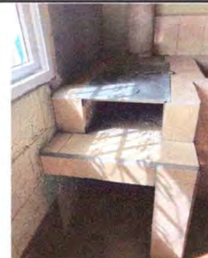
Foto 10: Reparacion de cocina de leña.
