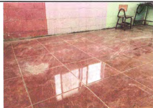
Foto 3: sustitución de piso cerámico
