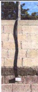
Foto 9: Sustitucion de instalacion electrica: tuberia, cableado interruptores y tomacorrientes en area de galera recepcion remodelada
