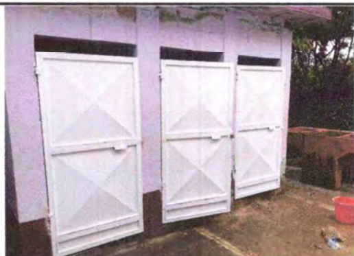
Foto 1: Reparación de puertas en área de baños
