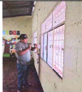
Foto 2: Sustitución de ventanas
