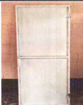
Foto 1: Reparación de puertas en área de baños
