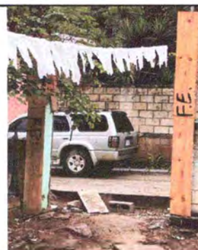
Foto 6: Reparación de porton de ingreso principal
