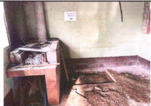
Foto 10: Reparacion de cocina de leña
