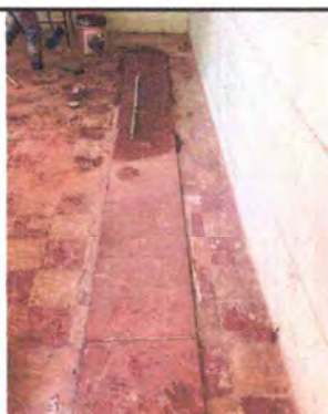
Foto 3: sustitución de piso cerámico
