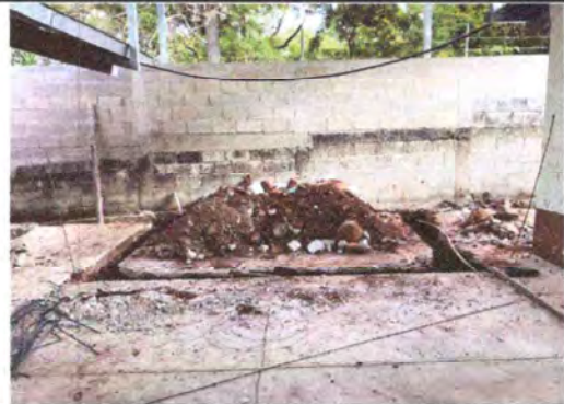
Foto 8: Sustitucion de losa de patio
