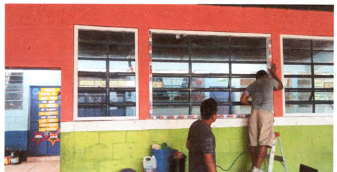
Foto4: CAMBIO DE VENTANAS TERMINADO
