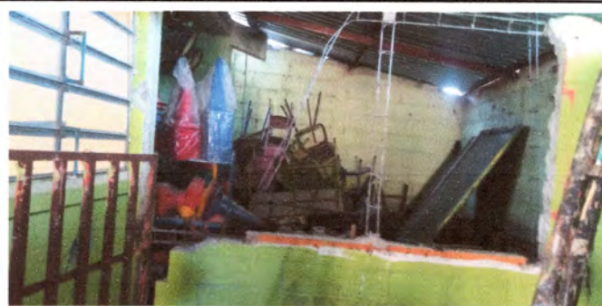
FOTO 2: TRABAJANDO REPARACIÓN DE PARED PARA CORREGIR GRIETAS
