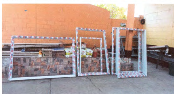
Foto4: TRABAJANDO CAMBIO DE VENTANERIA
