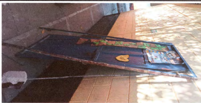
Foto: 5 REALIZANDO TRABAJO DE CAMBIO DE PUERTA
