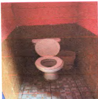
Foto1: SE REALIZARA EL CAMBIO DE SANITARIOS
