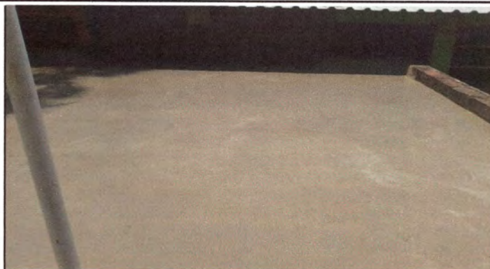
Foto1: SE REALIZO IMPERMEABILIZACION DE LOZA.
