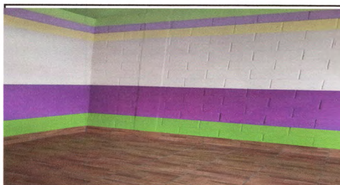
FOTO 4: SE REALIZO LA REPARACION EN EL PISO.
