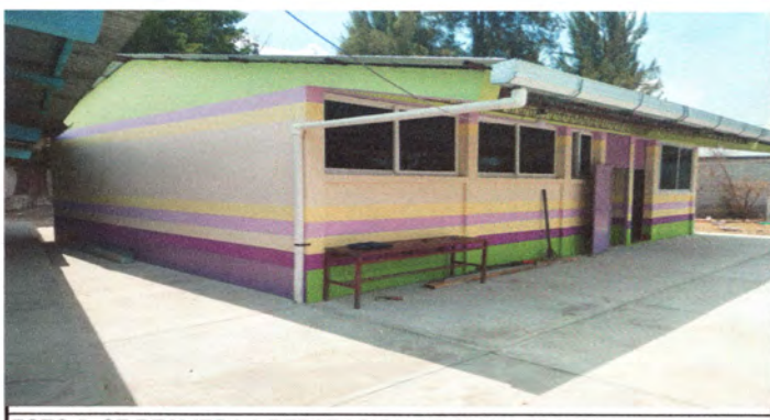
FOTO 5: SE REALIZO LA REPARACION DE CANALES Y BAJADAS DE AGUA PLUVIAL.
