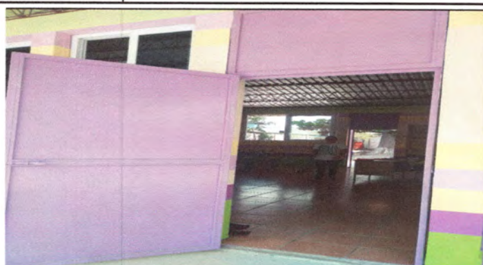
FOTO 2: SE REALIZO EL REMOSAMIENTO EN PUERTAS.
