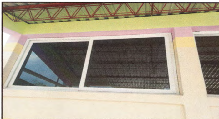
FOTO 3: SE REALIZO REPARACION EN VENTANAS.
