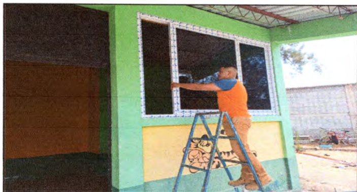
FOTO 3: REALIZANDO REPARACION DE VENTANAS.
