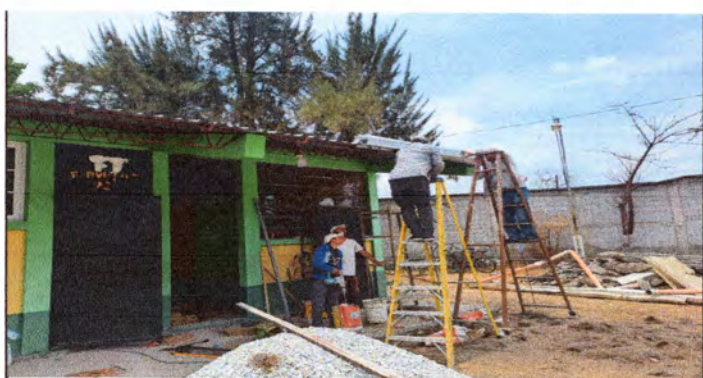
FOTO 7: REALIZANDO EL CAMBIO DE CANALES Y BAJADAS DE AGUA PLUVIAL.
