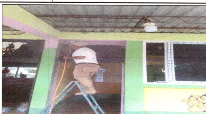
FOTO 2: REALIZANDO EL REMOSAMIENTO EN PUERTAS.
