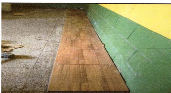
FOTO 4: REALIZANDO LA REPARACION DEL PISO.
