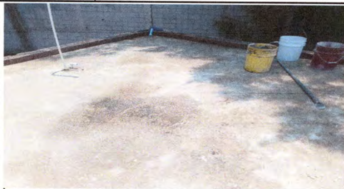
FOTO 1: REALIZANDO LA IMPERMEABILIZACION DE LOZA.
