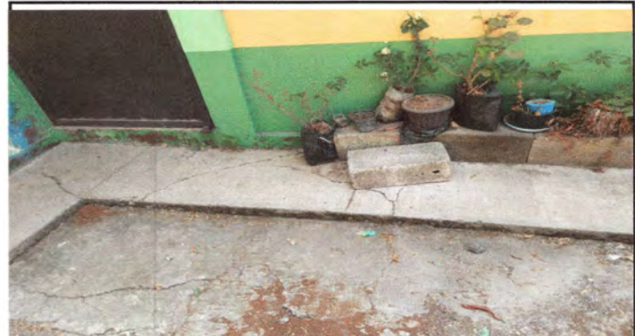
Foto 10: REMOSAMIENTO DE LOSA DE PATIO.
