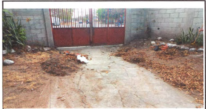
FOTO 8: SE REALIZARA MANTENIMIENTO DE PORTONES.
