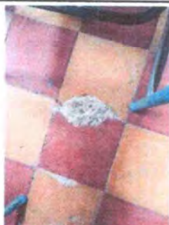
Foto 1: SUSTITUCION DE PISO
