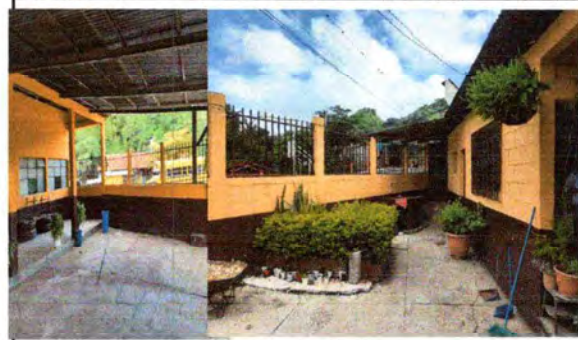
Foto 2: CERCO O MURO PERIMETRAL
