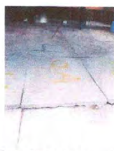
Foto 3: LOSA DE PATIO
