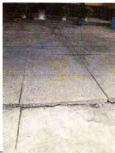
Foto 3: LOSA DE PATIO
