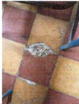
Foto1: SUSTITUCION DE PISO
