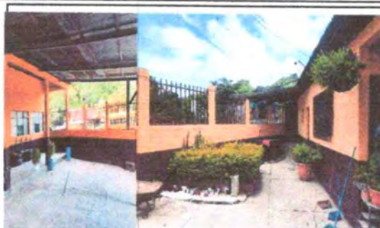
Foto 2: CERCO O MURO PERIMETRAL
