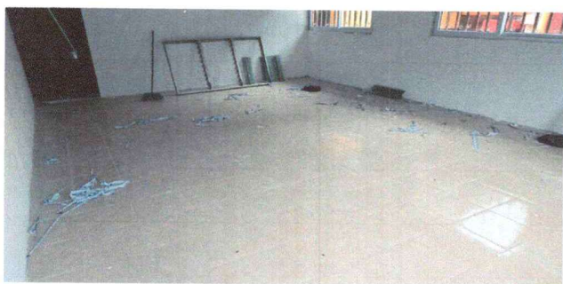
Colocación de piso
