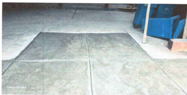
Losa de patio
