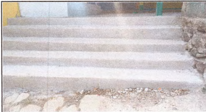
Foto 2: restauración de losa de cemento en gradas de ingreso de escuela.
