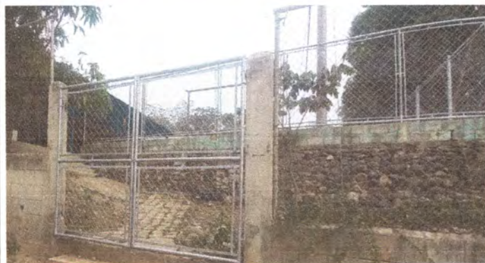
foto 3: reposicion de portón de acceso a escuela.
