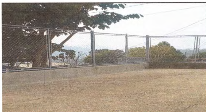
foto 4: Restauración de malla perimetral en cancha deportiva.
