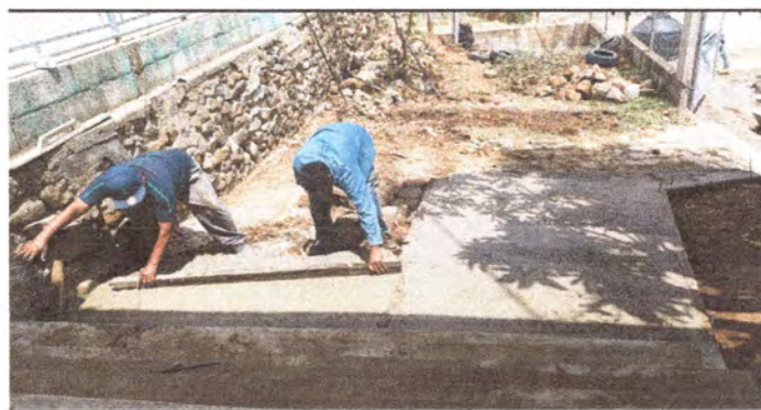
foto 6: Durante la aplicación de losa de cemento en área de entrada a la escuela.
