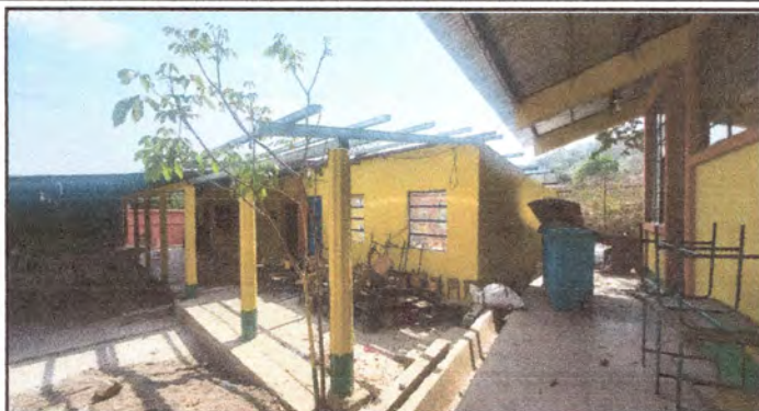
foto 1: Cambio de cubierta de lámina en aula.
