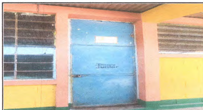
foto 4: Pintura de puertas de la escuela.
