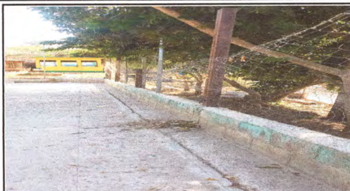
Foto 8: la restauración del muro perimetral en la cancha servirá para resguardar la seguridad de los estudiantes.
