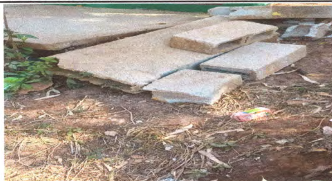
foto 9: Reparación de muro en sanitarios para salvaguardar la integridad física de los estudiantes
