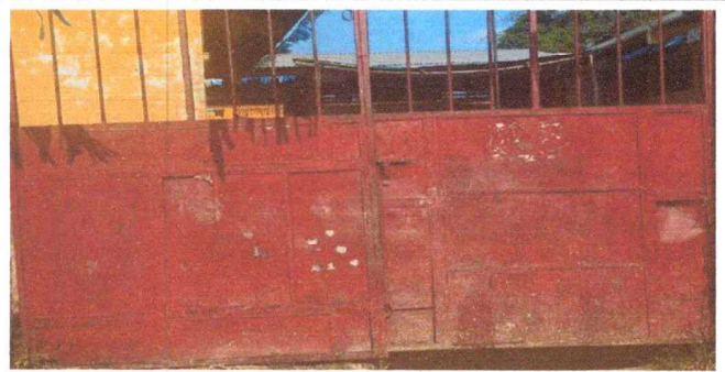
Foto 2: SUSTITUCIÓN DE PORTON DE TUBO CON MALLA
