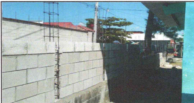
Foto1: SUSTITUCIÓN MURO PERIMETRAL BLOCK CISADO MAS COLUMNAS DE CONCRETO ESABIETADAS
