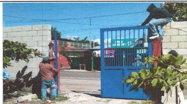
Foto 2: SUSTITUCIÓN DE PORTON DE TUBO CON MALLA
