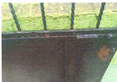
Foto 5: SUSTITUCION DE PORTON DE INGRESO
