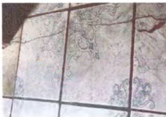
Foto 3: SUSTITUCION DE PISO CERAMICO
