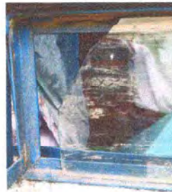
Foto 2: SUSTITUCION DE VENTANAS
