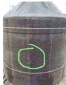
Foto 10: SUSTITUCION DE TICACO
