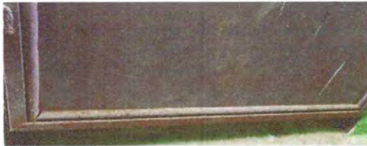
Foto 1: REPARACION DE PUERTAS
