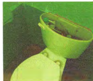
Foto 4: SUSTITUCION DE SERVICIOS SANITARIOS
