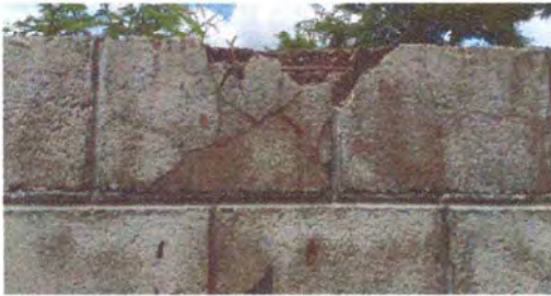
Foto 7: SUSTITUCION DE MURO PERIMETRAL
