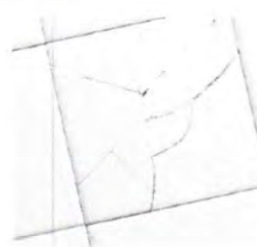
Foto 6: SUSTITUCION DE AZULEJO
