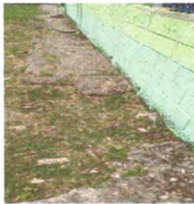
Foto 9: SUSTITUCION DE LOSA DE PATIO
