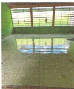
Foto 3: SUSTITUCION DE PISO CERAMICO
