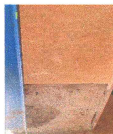
Foto 6: SUSTITUCION DE AZULEJO
