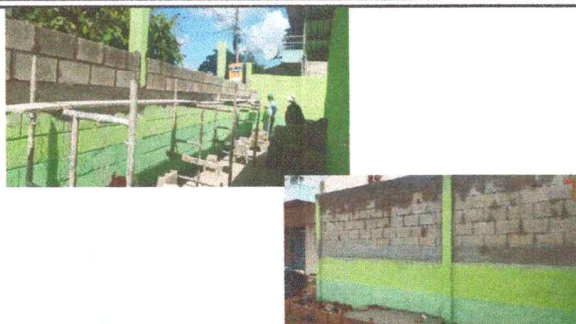
Foto7: SUSTITUCION DE MURO PERIMETRAL
