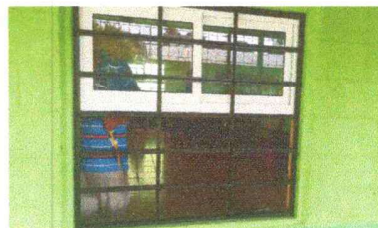
Foto 2: SUSTITUCION DE VENTANAS
