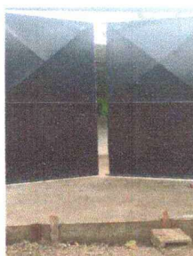
Foto 5: SUSTITUCION DE PORTON DE INGRESO
