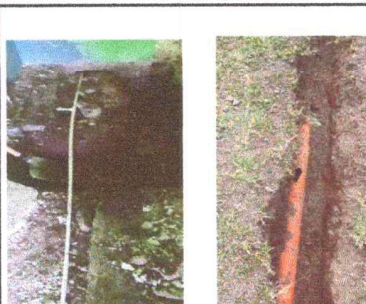
Foto 8: SUSTITUCION DE DRENAGES DE AGUAS NEGRAS Y AGUA POTABLE
