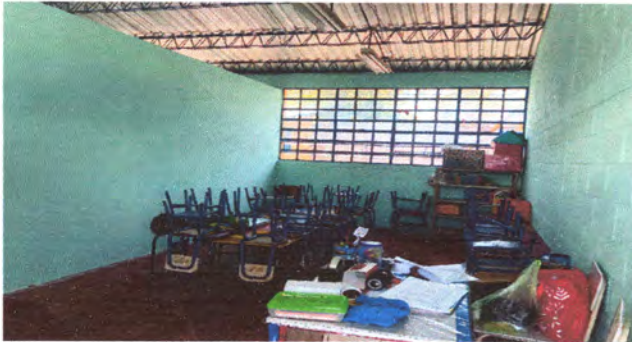
Foto1: Reparación de pared.
