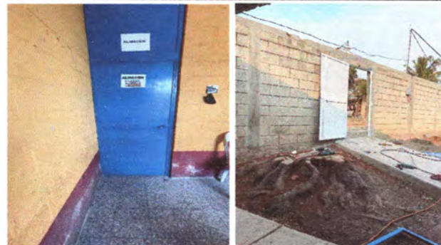
Foto3: Reparación y cambio de puertas.
