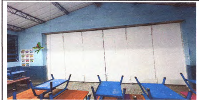
Foto: Reparación de puertas (contrachapado)
