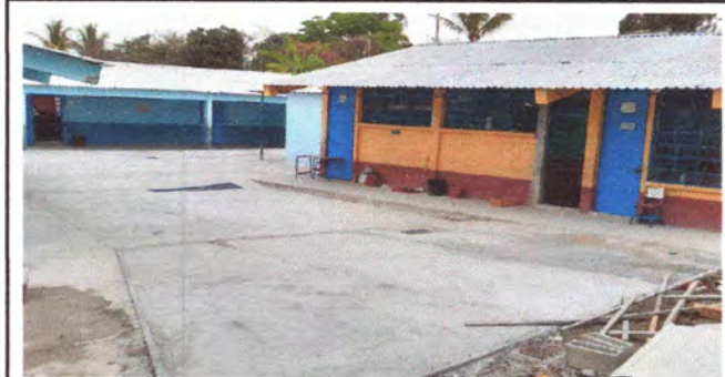
Foto4: Losa de patio.
