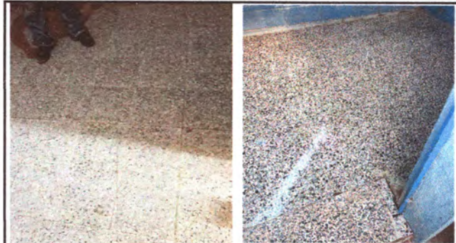
FOTO 2: Cambio de piso.
