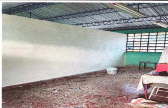
Foto1: Reparación de pared.
