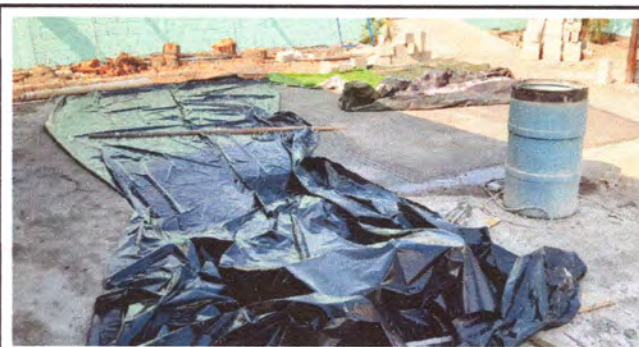
Foto4: Losa de patio.
