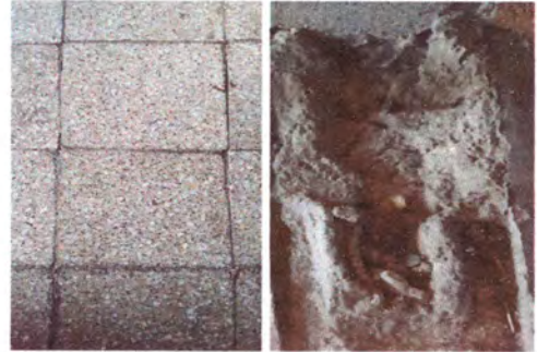
FOTO 2: Cambio de piso.
