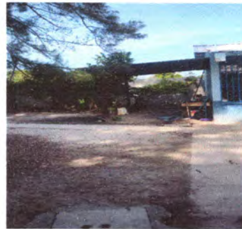
Foto4: Losa de patio.
