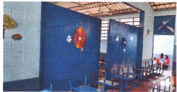
Foto: Reparación de puertas.
