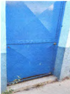
Foto3: Reparación y cambio de puertas.
