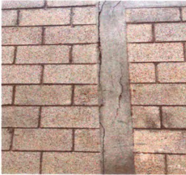
Foto1: Reparación de pared.
