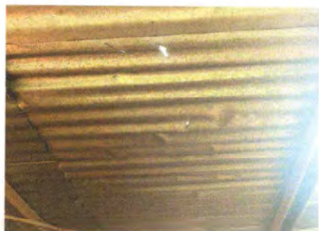
Foto1: cambio de lámina (acanalada a troquelada)
