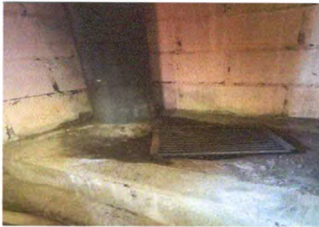
Foto 3: Reparación de área de cocina
