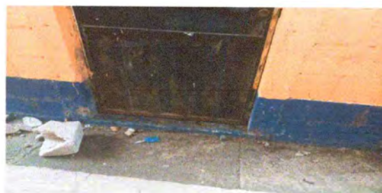
Foto 4: Mantenimiento de puerta
