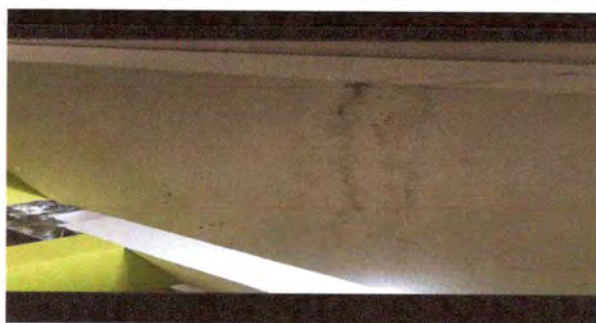
Foto 3: Impermeabilización de losa
