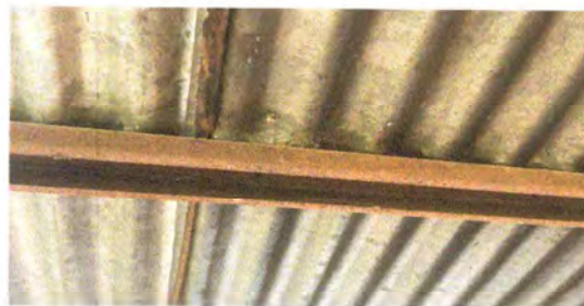
Foto 2: estructura de techo ( cambio de costanera)
