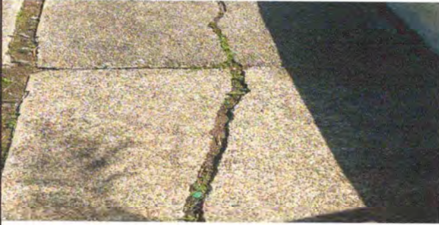
Foto1: Sustitución Losa Patio
