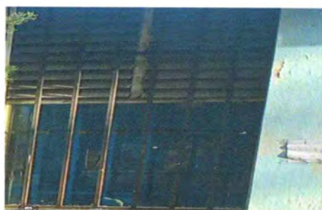
Foto 5: Sustitución de ventanas
