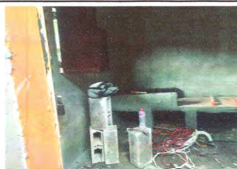
Foto 2: colocación de sustitución de plancha
