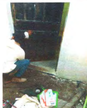
Foto 4: Proceso de Mantenimiento de puerta de cocina
