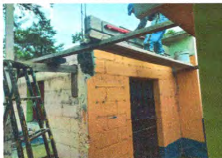
Foto 2: colocación de proceso de techo
