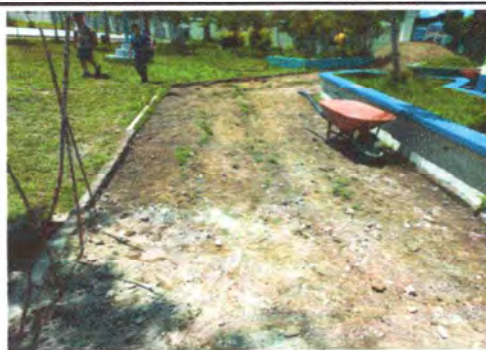
Foto 6: Proceso de sustitución de losa patio
