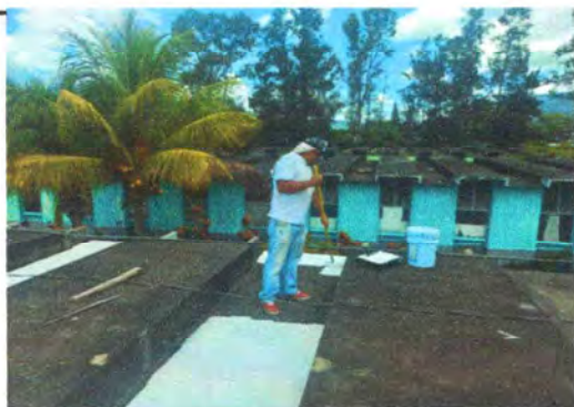
Foto 3: proceso impermeabilización de losa techo
