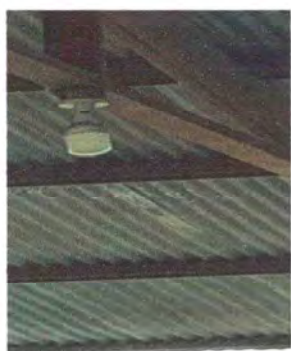
Foto 3: reparacion de sistema electrico
