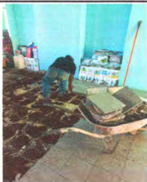
Foto1: proceso de sustitución de piso
