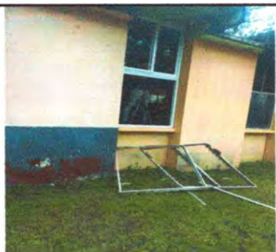
Foto 5: proceso de sustitución de ventanas
