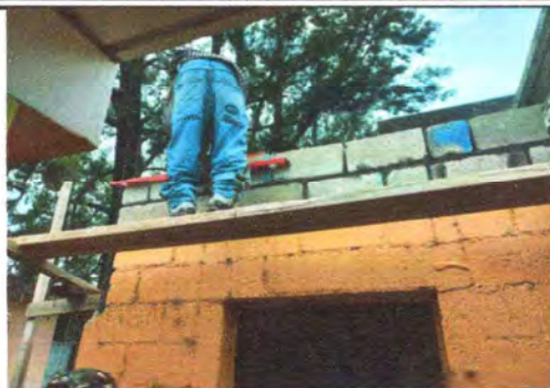
Foto1: proceso de cambio de techo
