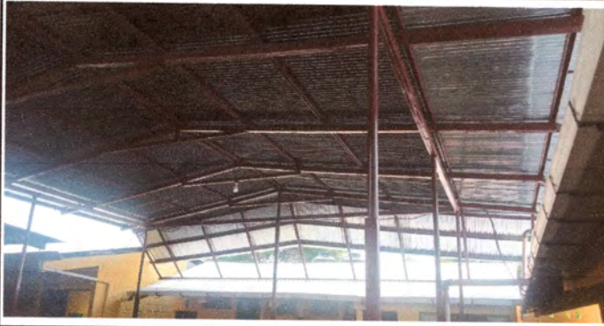
Foto1: TERMINADO EL LEVANTADO DE LA CUBIERTA DE TECHO MAS PINTURA
