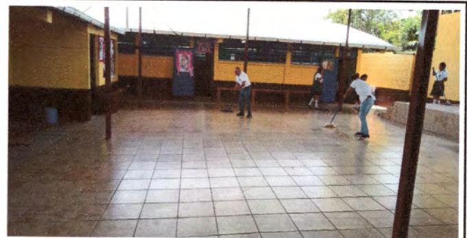
Foto: 6 TERMINADO CAMBIO DE CANAL DAÑADO
