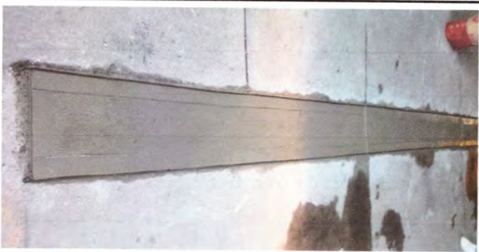
Foto 5 CAMBIO DE DRENAJE TERMINADO
