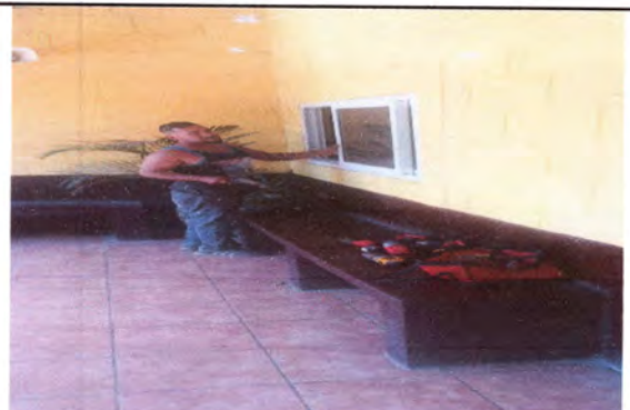
Foto4: TRABAJANDO EL CAMBIO DE VENTANAS
