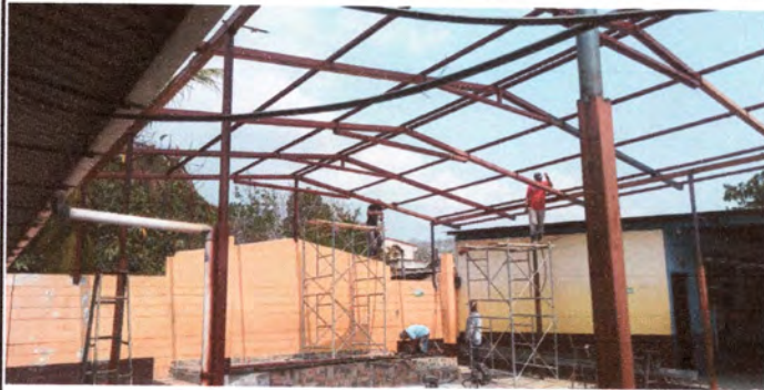
Foto1: TRABAJANDO EL LEVANTADO DE LA CUBIERTA DE TECHO MAS PINTURA
