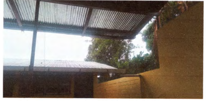
Foto: 6 TRABAJANDO EL CANAL DEL SALON
