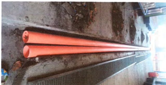
Foto: 5 TRABAJANDO EL CAMBIO DE DRENAJE Y RECUBRIMIENTO DE LOSA A TUBERIA EXPUESTA
