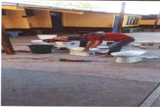
Foto3: TRABAJANDO EL CAMBIO DE SANITARIOS
