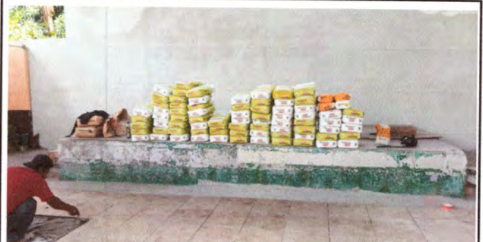
FOTO 2: TRABAJANDO REMOZAMIENTO DE LA LOSA MAS COLOCACION DE PISO
