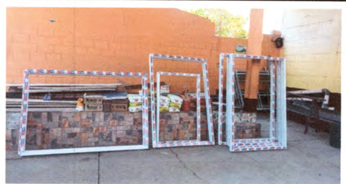
Foto4: TRABAJANDO CAMBIO DE VENTANERIA
