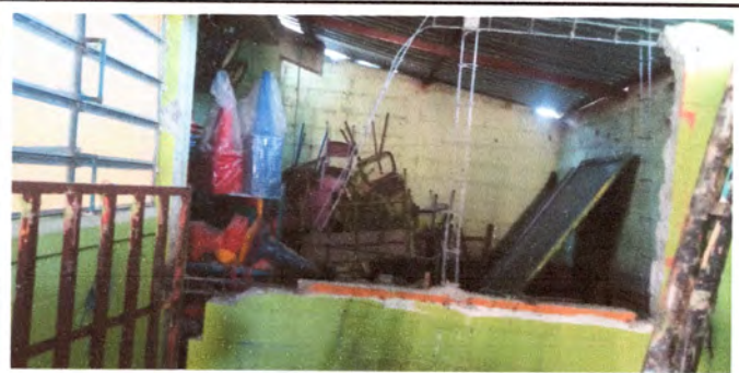
FOTO 2: TRABAJANDO REPARACIÓN DE PARED PARA CORREGIR GRIETAS
