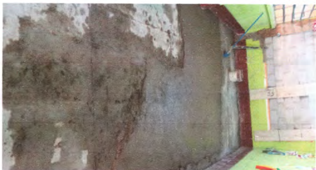
Foto3: REMOZAMIENTO DE LOZA
