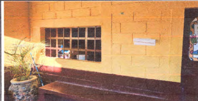
Foto4: SE REALIZARA EL CAMBIO DE VENTANAS
