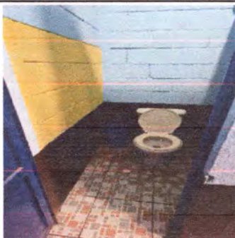
Foto3: SE REALIZARA EL CAMBIO DE SANITARIOS
