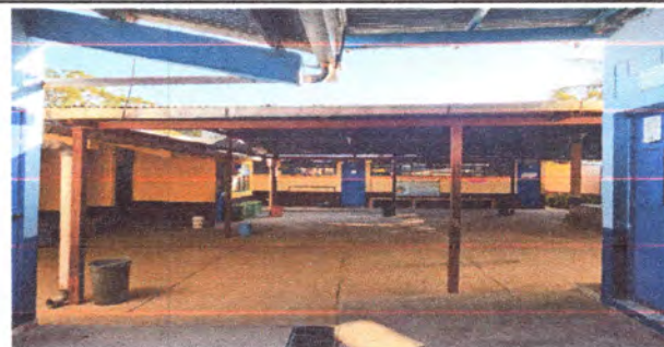
Foto: 6 SE REALIZARA EL CAMBIO DE CANALES DAÑADOS
