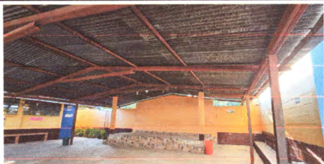
Foto1: SE REALIZARA EL LEVANTADO DE LA CUBIERTA DE TECHO MAS PINTURA
