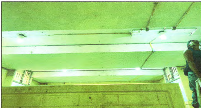
Foto1: REMOZAMIENTO DE RED ELECTRICA DE LA COCINA.
