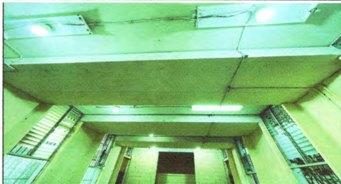
FOTO 2: REMOZAMIENTO DE RED ELECTRICA DE LA COCINA.
