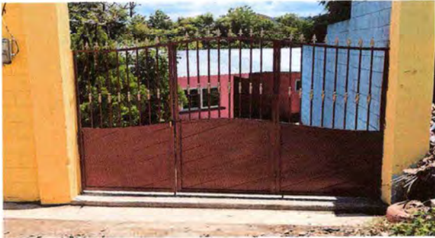
Foto 7: Portón cambiado 100% de avance
