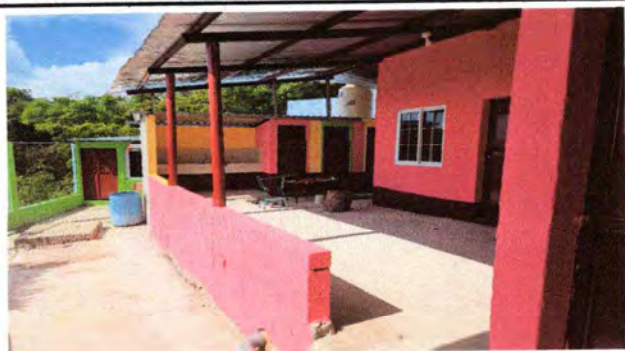
Foto1: Techo de baños 100% de avance
