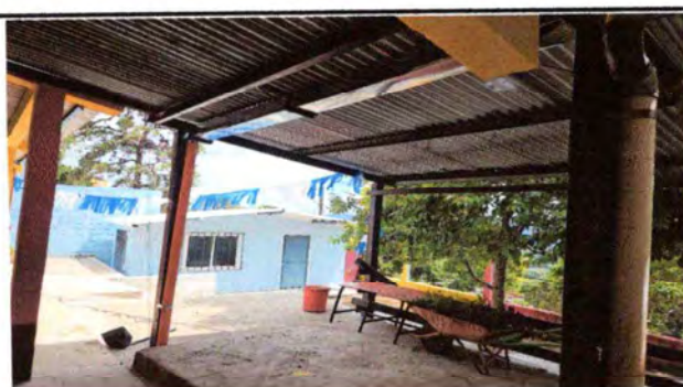
Foto 6: Colocación de canal 100% de avance
