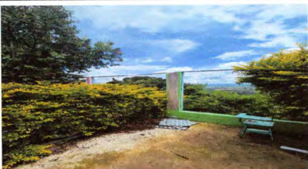
Foto 11: Mantenimiento de muro perimetral 100% de avance
