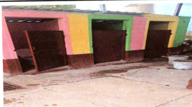
Foto 3: Puertas de sanitarios cambiadas 100% de avance
