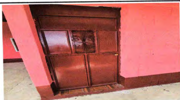
Foto 5: Puertas con pintura y chapas 100% de avance
