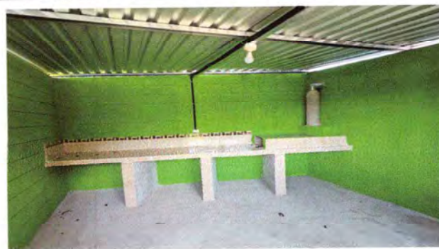
Foto 2: Cambio de Techo en cocina 100% de avance
