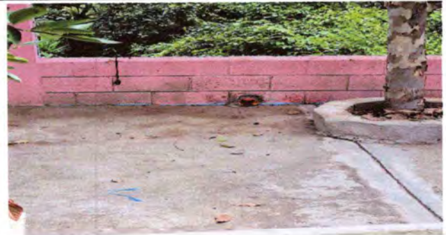
Foto 12: Mantenimiento de muro perimetral 100% de avance
