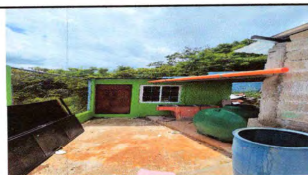
Foto 2: Ventana y puerta en cocina 100% de avance
