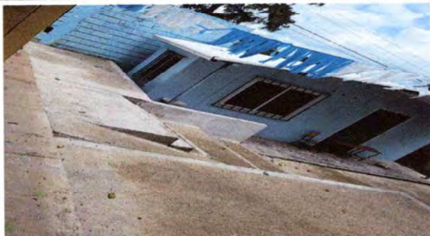
Foto 9: Losa de patio terminada 100% de avance
