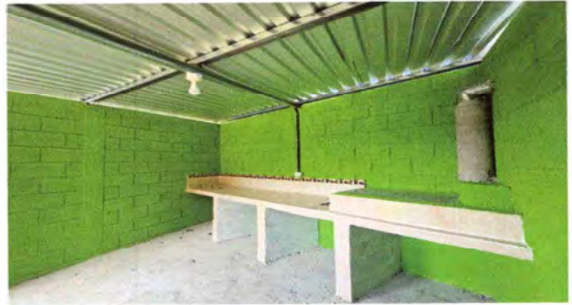
Foto 10: Sistema eléctrico reparado 100% de avance
