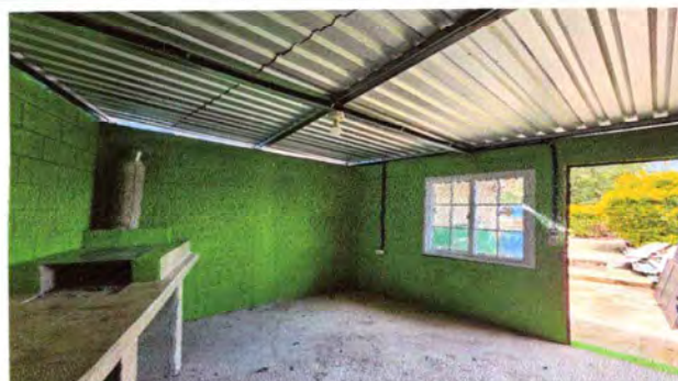
Foto 2: Ventana y puerta de cocina 75% de avance
