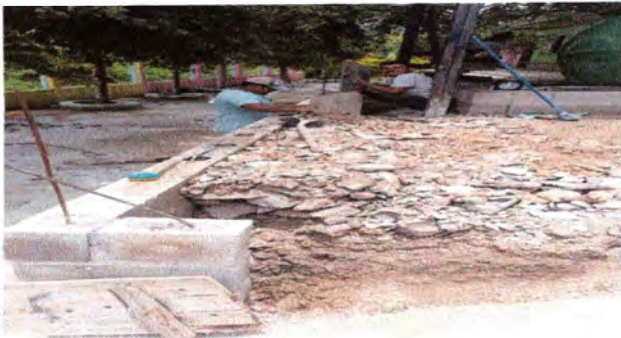
Foto 9: Losa de patio 50% de avance
