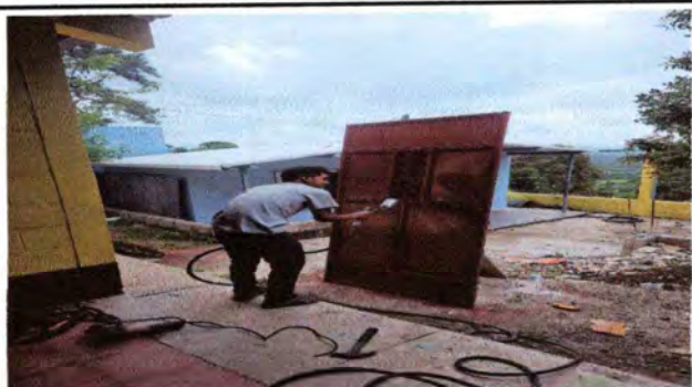
Foto 5: Mantenimiento a puertas con pintura y chapa 50% de avance
