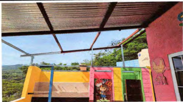
Foto1: Techo de baños y lavamanos 50% de avance
