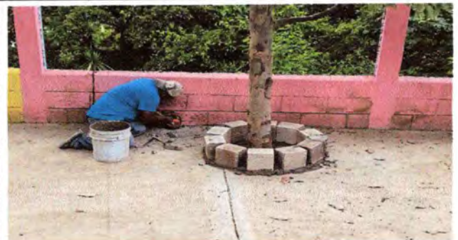
Foto 12: Muro perimetral 75% de avance
