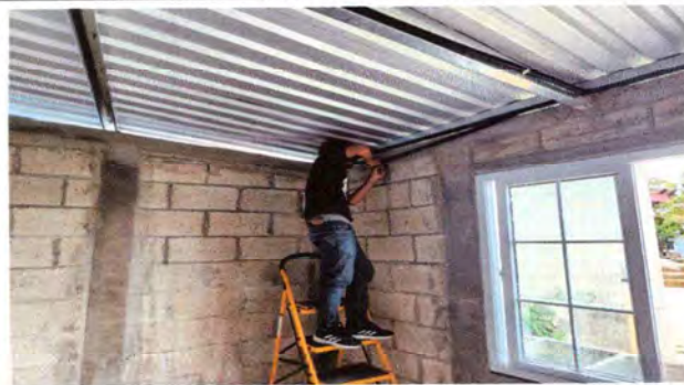
Foto 2: Techo de cocina 90% de avance
