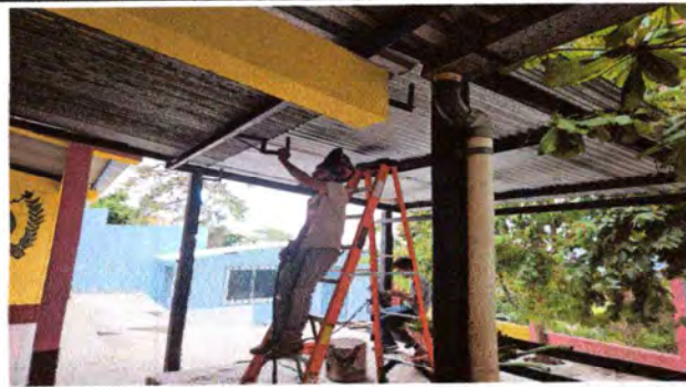
Foto 6: Sustitución de canal y bajada de agua pluvial 50% de avance
