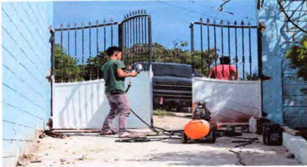
Foto 7: Portón 50% de avance
