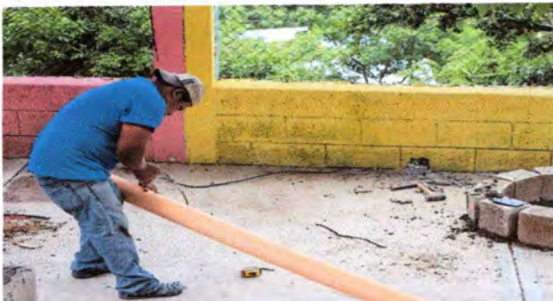
Foto 11: Muro perimetral 75% de avance
