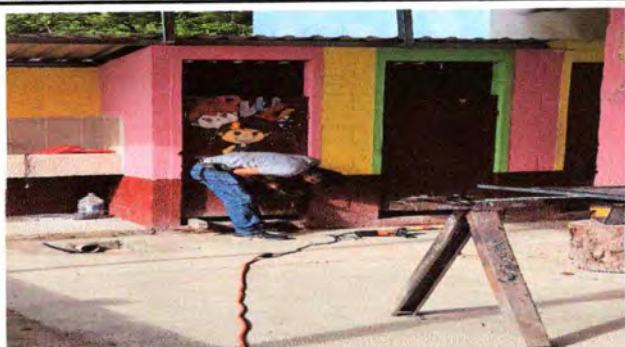
Foto 3: Puertas de sanitarios 40% de avance
