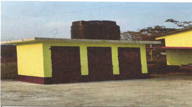
Foto 3: baños remozados, cambio de puertas y tinaco.
