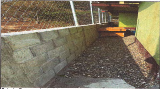
Foto 1: Remozamiento del muro perimetral.
