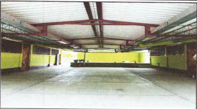
FOTO 2: Cambio de cubierta finalizado.
