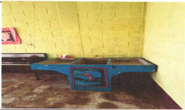
Foto 6: cambio de pila y tubería de agua potable remozada.
