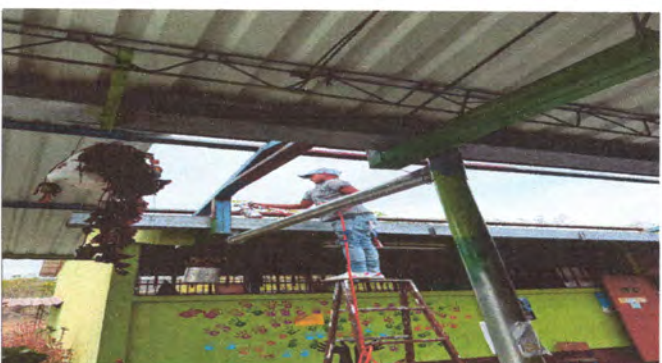
Foto 4: pintura de estructura para colocar la nueva cubierta.
