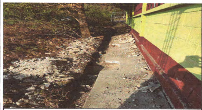
Foto 5: preparativos para el cambio del muro.
