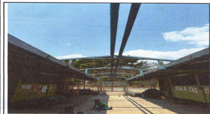
Foto 3: situación actual durante el cambio de cubierta.
