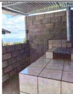
FOTO 4.2. SUSTITUCION MURO PERIMETRAL BLOCK CISADO MAS COLUMNAS DE CONCRETO.
