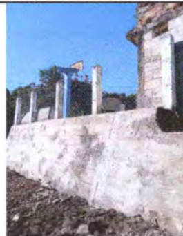
FOTO 4.1. SUSTITUCION DE CERCO PERIMETRAL CON BLOCK Y MALLA.
