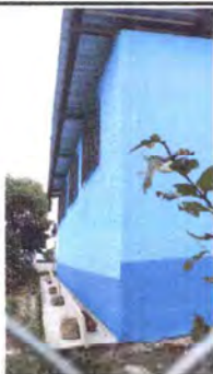
FOTO 3.1. SUSTITUCION DE PINTURA BASE AGUA.
