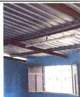
FOTO 5.1. SUSTITUCION DE LAMPARAS LED INCLUYE INTERRUPTOR.
