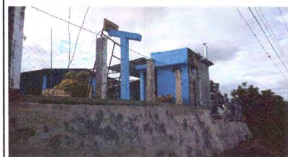
FOTO 8.1. SUSTITUCION MURO DE CONCRETO CICLOPEO.
