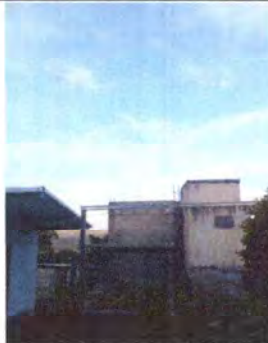
FOTO 1.1. SE SUSTITUCION LAMINA TROQUELADA.
