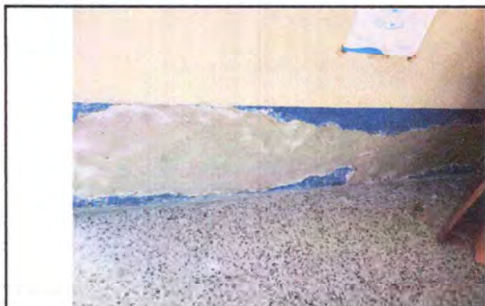
FOTO 6.1. SUSTITUCION DE REPELLO Y CERNIDO.
