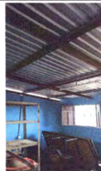
FOTO 2.1. SUSTITUCION ESTRUCTURA DE TECHO.
