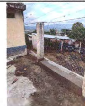
FOTO 4.1. SUSTITUCION DE CERCO PERIMETRAL CON BLOCK Y MALLA.
