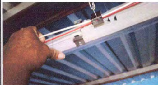
FOTO 5.3. SUSITUCION DE CABLEADO CALIBRE 12 MAS DUCTO PVC SOBREPUESTO
