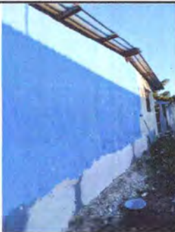
FOTO 3.1. SUSTITUCION DE PINTURA BASE AGUA.
