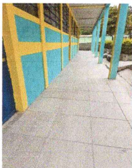
Foto 1: SUSTITUCIÓN PISO CERÁMICO
