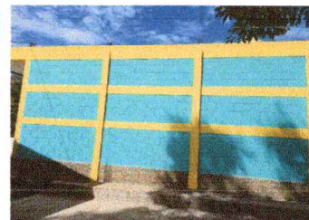
Foto 2: SUSTITUCIÓN DE PINTURA BASE AGUA
