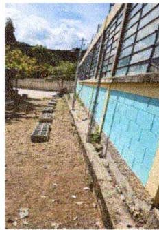
Foto 3: SUSTITUCIÓN DE CERCO PERIMETRAL CON BLOCK Y MALLA
