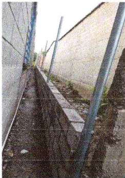
Foto 3: SUSTITUCIÓN DE CERCO PERIMETRAL CON BLOCK Y MALLA
