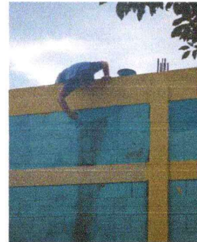
Foto 2: SUSTITUCIÓN DE PINTURA BASE AGUA
