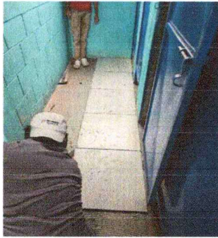
Foto 1: Sustitución Piso Cerámico
