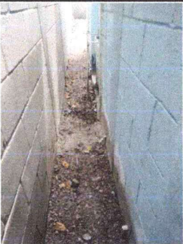
FOTO 3: Reparación de red de drenajes
