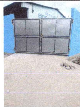
FOTO 2: Mantenimiento de Portones
