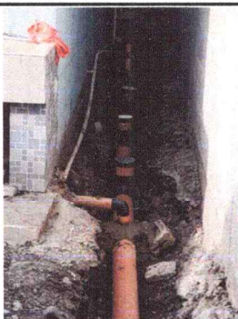
FOTO 3: Reparación de red de drenajes
