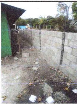
FOTO 4: Cerco o muro perimetral
