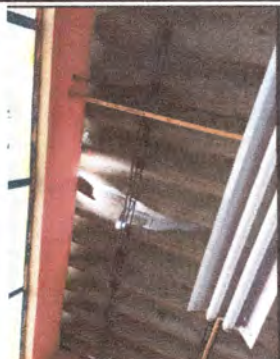
Foto1: Levantar cubierta de lamina tipo duralita a 698 mts2, colocar estructura metalica y colocar lamina nueva tipo acanalada
