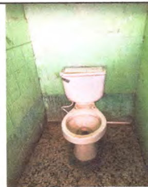
Foto: 5 desinstalar 3 sanitarios, reparar modulo, reparar drenajes, instalar un migitorio e instalar sanitarios nuevos. (lado de niños)
