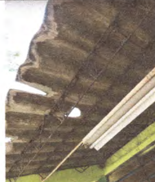
FOTO 2: Levantar cubierta de lamina tipo duralita a 432 mts2, pintar estructura metalica, reforzar la estructura metalica y colocar cubierta de lamina nueva tipo acanalada.
