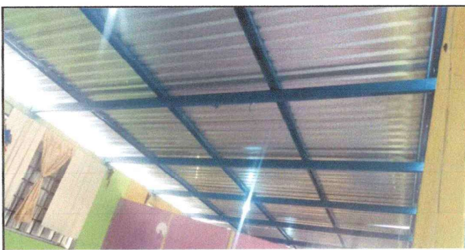
lamina troquelada calibre 26 y mantenimiento de estructura de soporte
