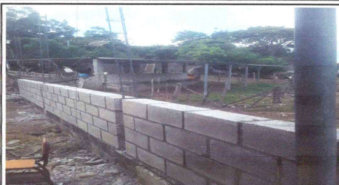
parte posterior en proceso de levantado de muro de block
