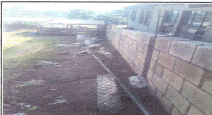
lateral izquierdo en proceso de levantado de muro de block
