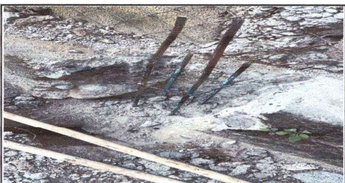
lateral derecho, fundición de zapatas y anclaje de columnas nuevas.
