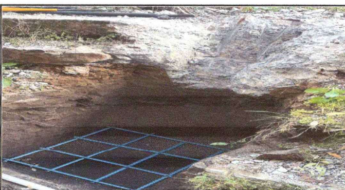
lateral derecho fundición de zapatas para muro de block
