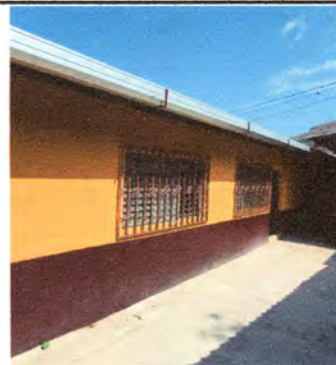
Foto 2: Se cambió el Canal de Agua.
