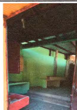
Foto 4: Se remodeló la cocina.
