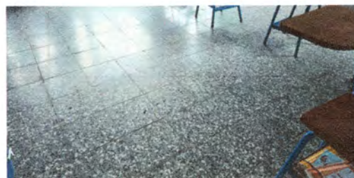
Foto 6: cambio de piso aula
