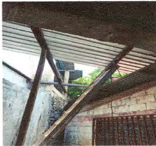
Foto 5: CAMBIO DE LAMINA COCINA
