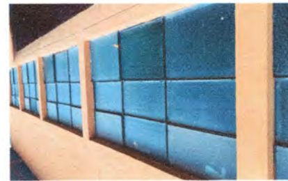
Foto 6: CAMBIO DE PINTURA DETERIORADA
