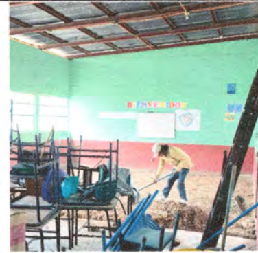
Foto 4: Se cambió piso por encontrarse en mal estado.
